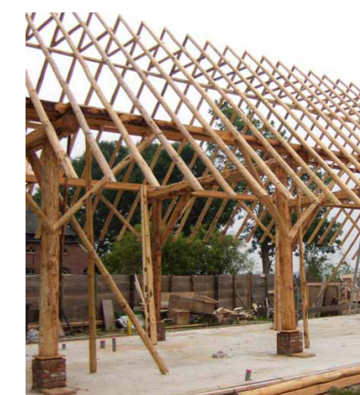
Referentie constructie: historische gebinten constructie oude Groningse schuur.
